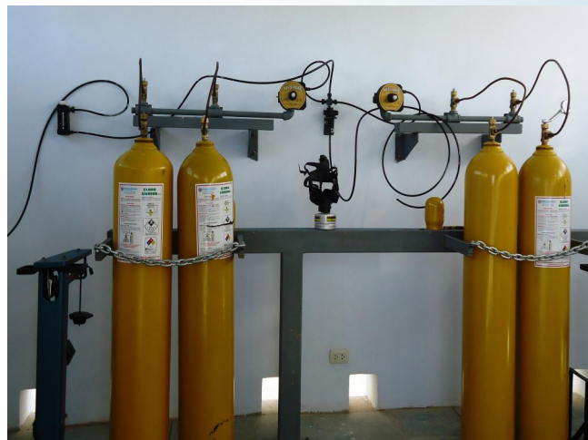
Sistema de cloración con transferencia automática
