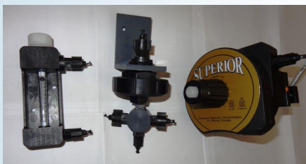
Componentes del clorador
